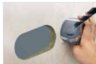
3. Conduit / Cable Penetration Cutting
